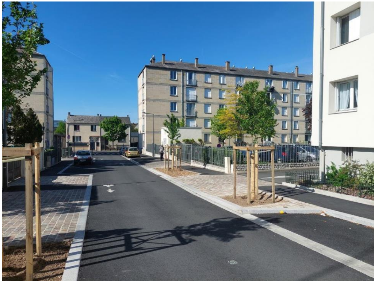
début des travaux
