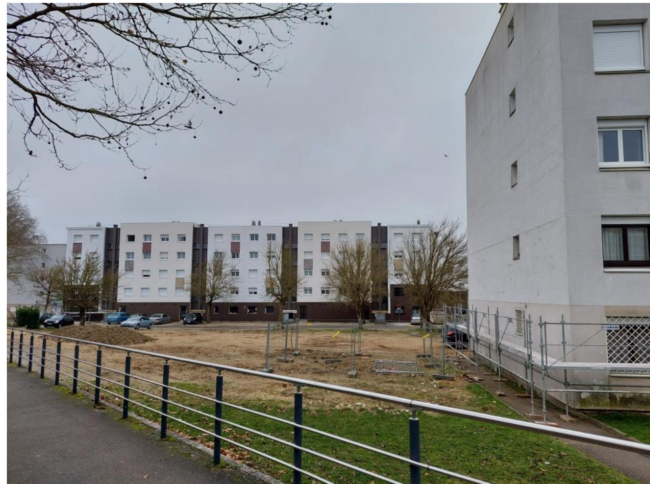
démolition 1 er immeuble
