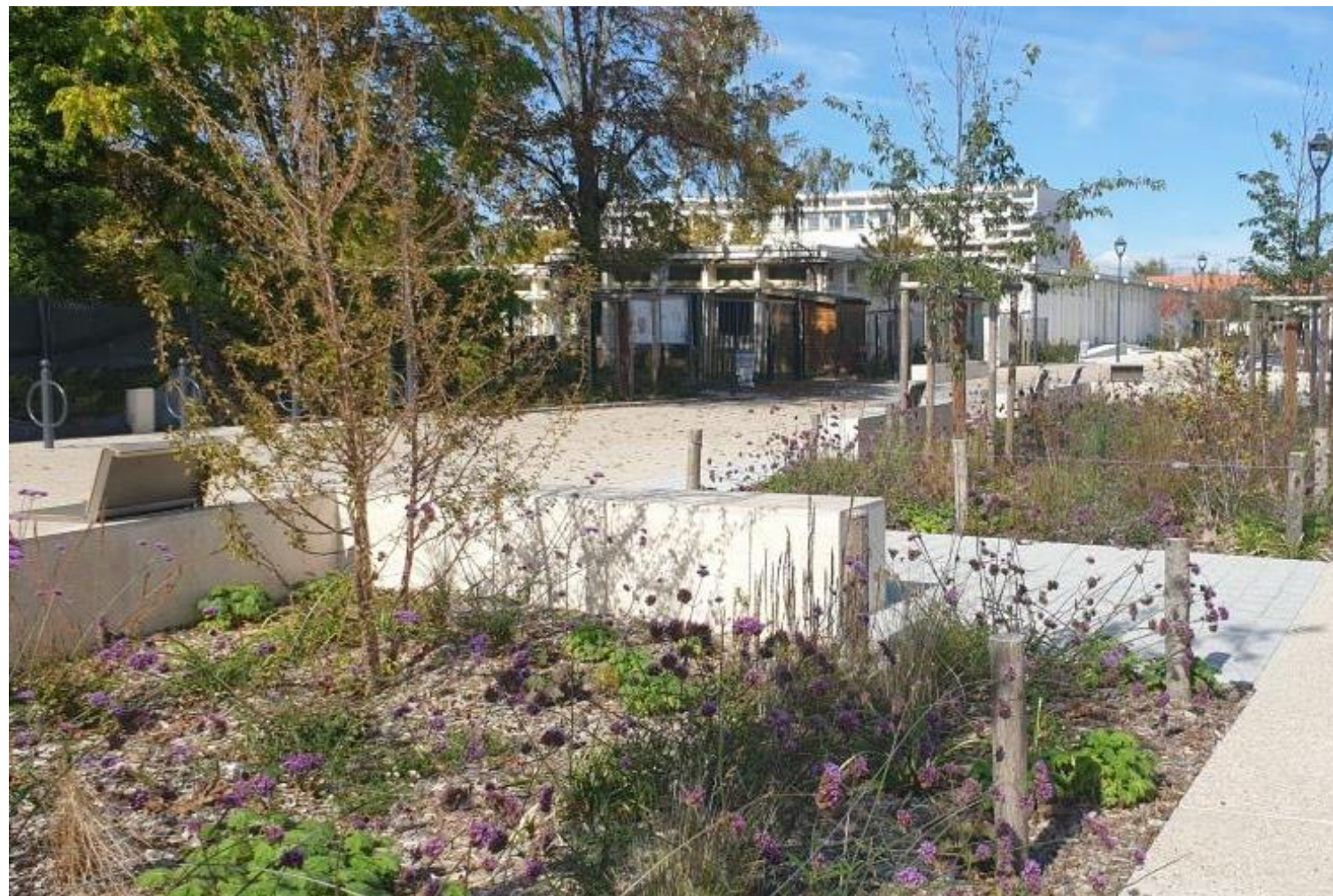
début des travaux
