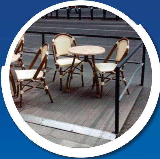
**Les planchers** sont en **bois traité** de qualité et les rives en acier inoxydable. Ils sont installés sur voirie et lorsque la pente du trottoir le nécessite.
