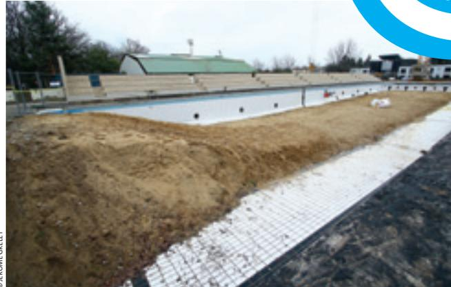
La structure de l'ancien grand bassin est conservée. Une cuve moulée en inox, qui en épousera les dimensions, sera déposée à l'intérieur.
