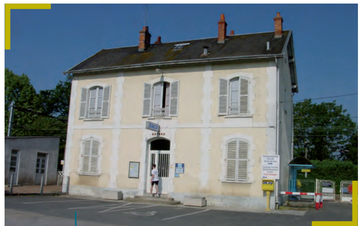
Gare de Saint-Cyr-en-Val. Source : AUAO
