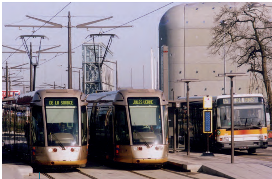
Station intermodale Zénith-Parc des expositions. Source : AUAO
