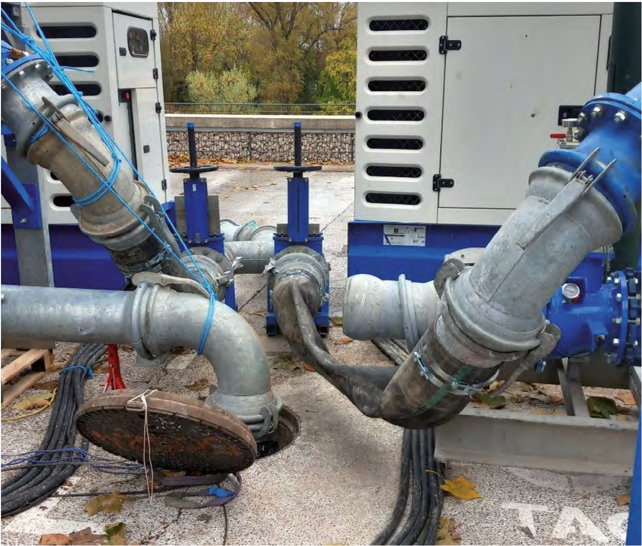
Pompage provisoire quai du Roi à Orléans
