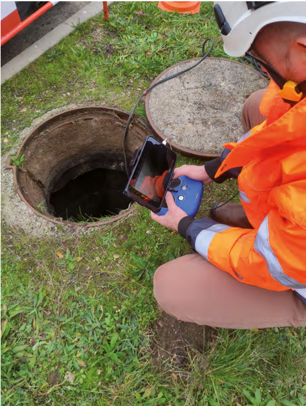
Technicien réalisant un passage caméra dans un réseau
