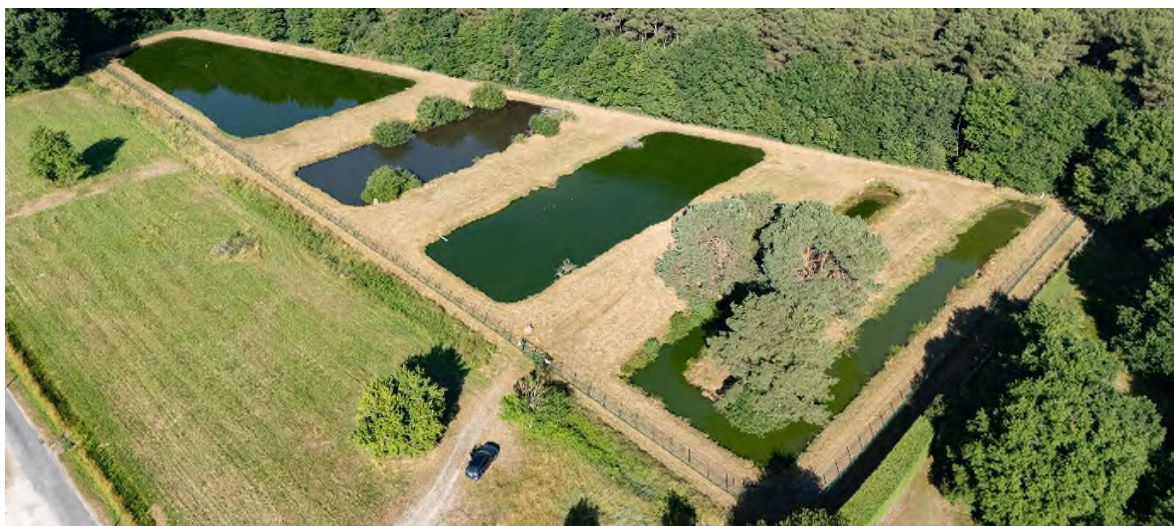
Vue aérienne de la station d'épuration Berceau – Chanteau (Photo prise par Didier DEPOORTER)
