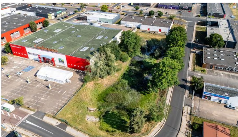
Bassin d'orage de la zone commerciale de Saran (photo prise par Didier DEPOORTER)
