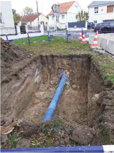
1-dégagement de la canalisation existante
