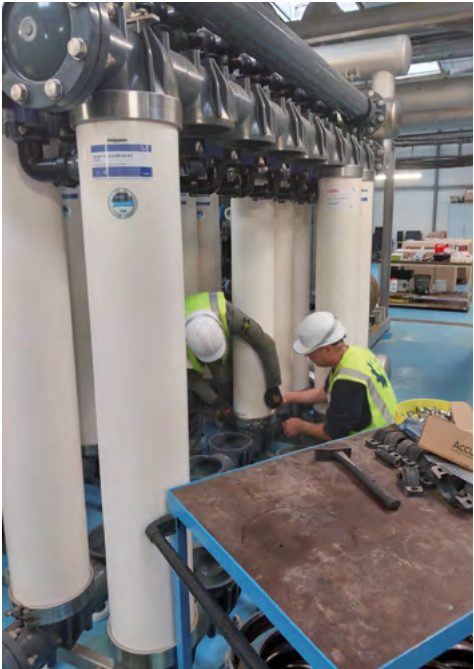
Renouvellement des modules d'ultrafiltration
