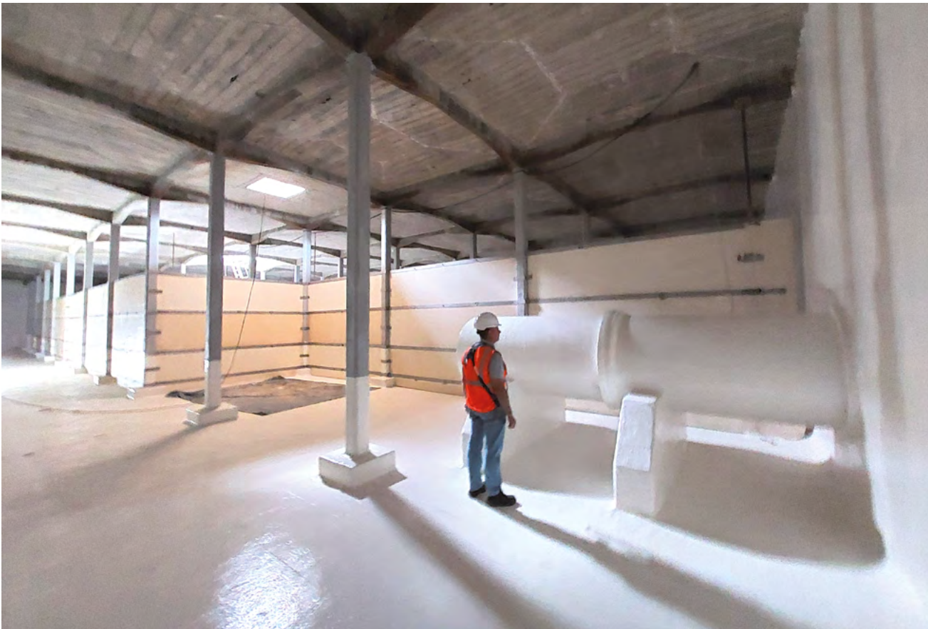
Réservoir de Chaude Tuile – étanchéification des cuves
