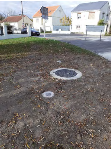
3-remblais et mise à niveau des bouches à clés et tampon du regard de visite
