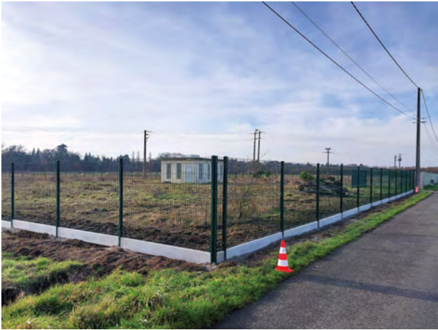
Réfection de la clôture du Bouchet à Orléans
