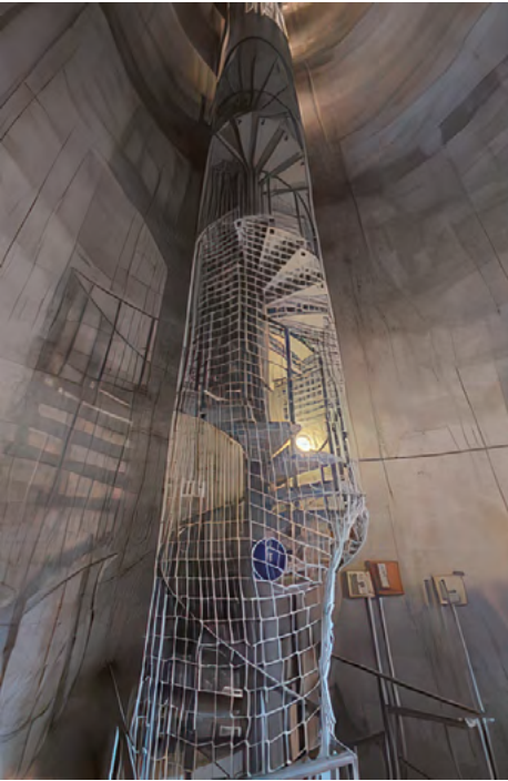
Pose d’un filet de sécurité et d’une trappe - Réservoir de Chécy
