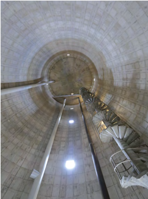
Intérieur du réservoir de Fosse Belaude – Saint-Jean de Braye ©Benoît VOISIN
