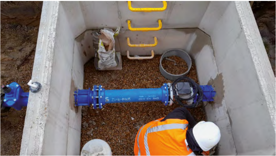
2-pose réductions, vannes et débitmètre de sectorisation et regard de visite
