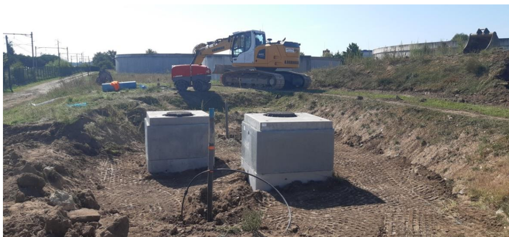
Usine du Val : renouvellement du débitmètre sur une conduite de 700mm
