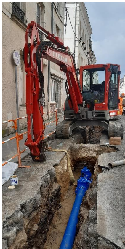
Renouvellement d'une conduite en fonte rue de Bourgogne – Orléans
