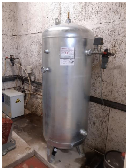
St Jean de Braye - usine de Fosse Belaude - renouvellement du ballon d'air comprimé
