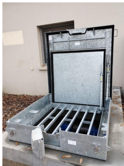
Forage de Boigny - installation d'une trappe haute sécurité
