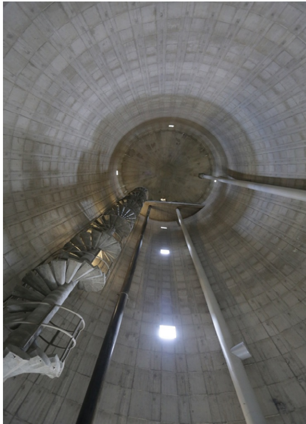
Intérieur du réservoir de Fosse Belaude (photo prise par Benoît VOISIN)
