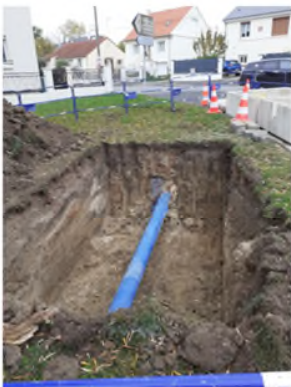
1. Dégagement de la canalisation existante
