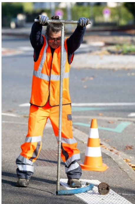
Agent fontainier en intervention (photo prise par Didier DEPOORTER)
