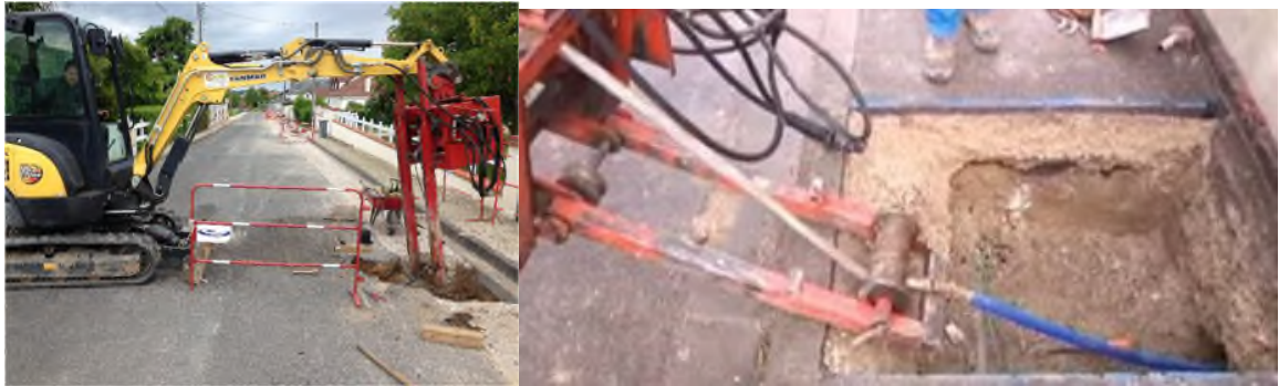
Suppression d'un branchement en plomb quartier Hardouin Mansard – La Chapelle-Saint-Mesmin
