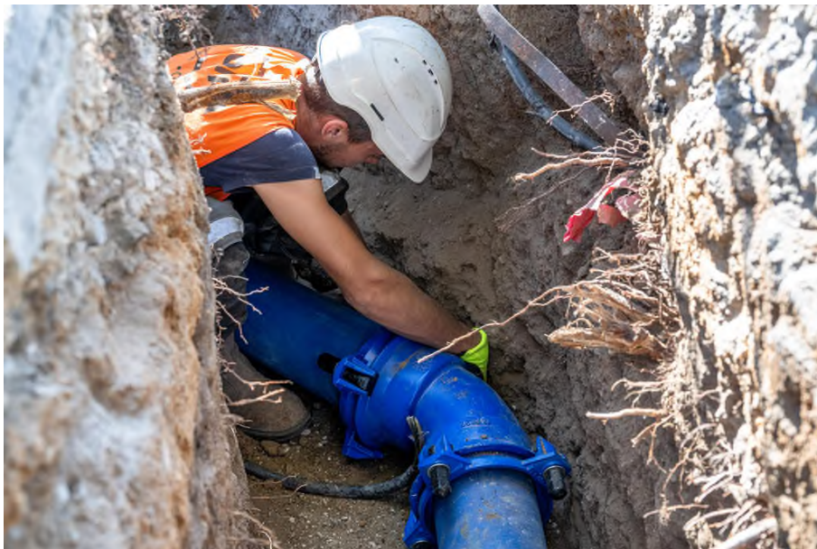
Agent en intervention sur le réseau d'eau potable (photo prise par Didier DEPOORTER)
