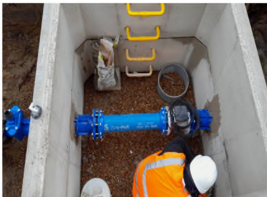
2. Pose réductions, vannes et débitmètre de sectorisation + 1 regard de visite
