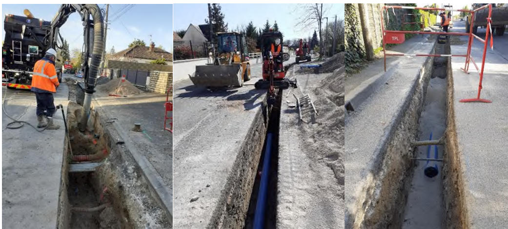
Renouvellement réseau – Rue du petit Vomimbert – Saint Jean de Braye
