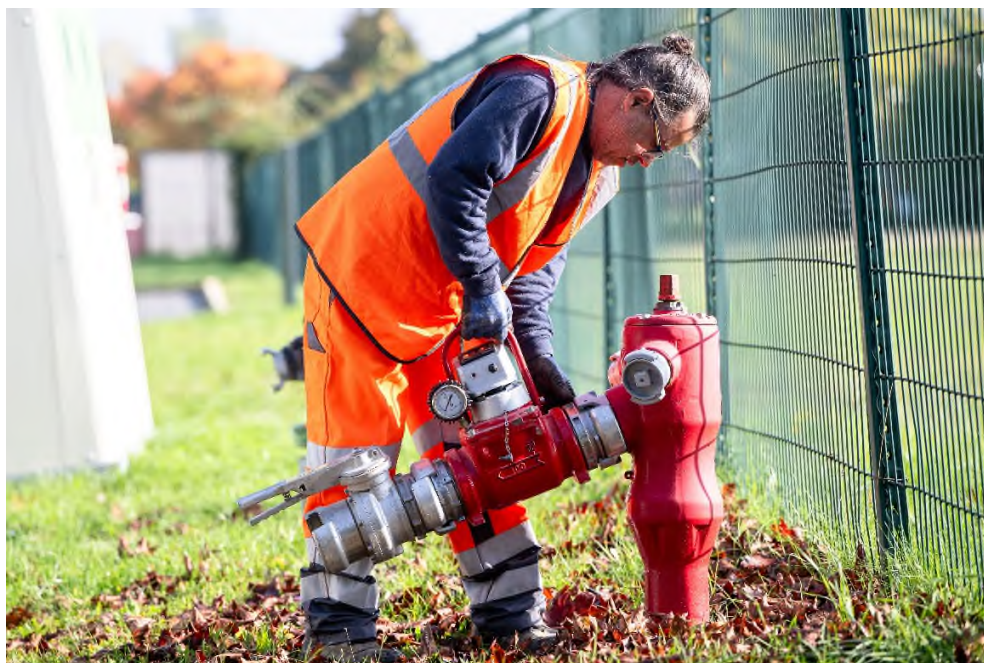
Agent de la DCE en intervention sur un poteau incendie (photo prise par Didier DEPOORTER)
