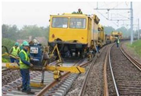
Longs Rails soudés sur traverses béton
