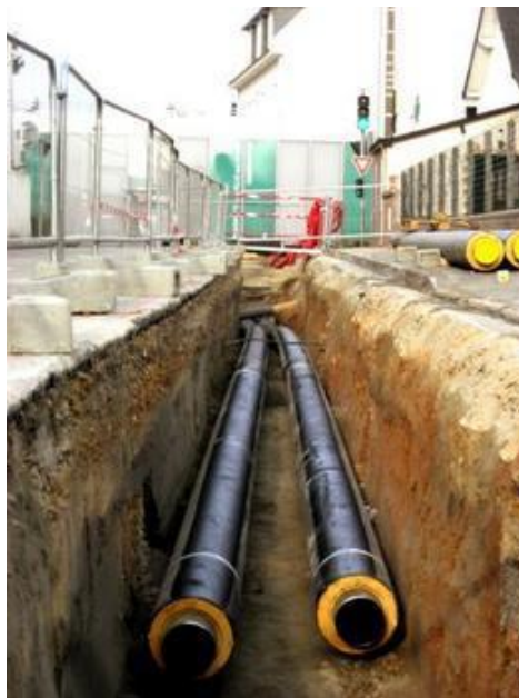
FIGURE 4: ILLUSTRATION DE CANALISATIONS D'UN RESEAU DE CHALEUR
