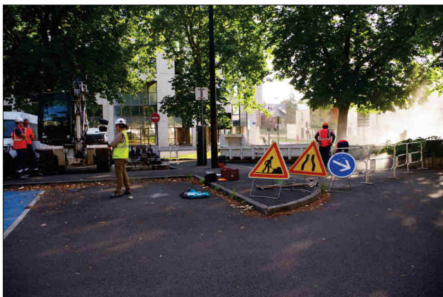
Fig. 31 : Contexte du terrassement du sondage M1 (PAVO).
