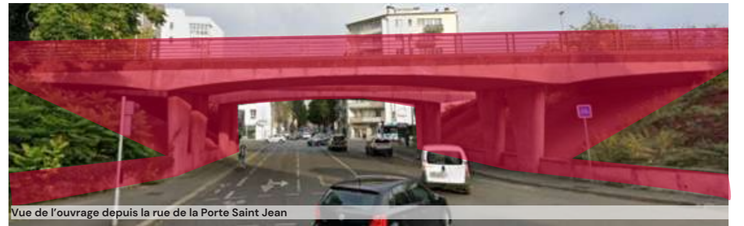
Vue de l'ouvrage depuis la rue de la Porte Saint Jean
