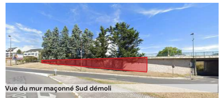
Vue du mur maçonné Sud
