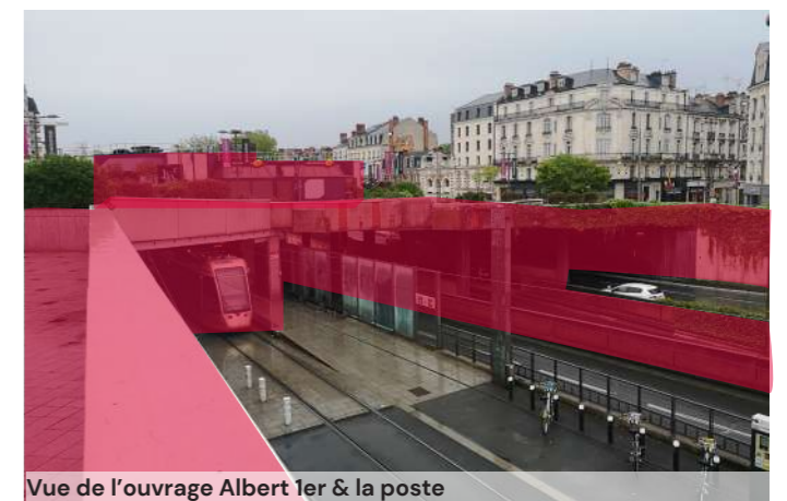
Figure 1 - Vue aérienne de l'ouvrage actuel et repérage des démolitions (en rouge)
