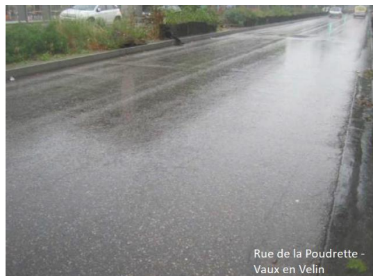
Exemple de chaussée structure réservoir étanche avec injection localisée (source : Eurométropole de Lille) et chaussée structure réservoir infiltrante (rue de la Poudrette – source : Observatoire Auvergne-Rhône-Alpes)
