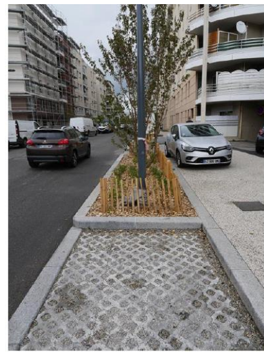
Exemple de tranchée d'infiltration avec alimentation superficielle (source : Eurométropole de Lille) et tranchée drainante sous Place de stationnements et noue (« Trame brune » - Rue Emile Decorps, 69100 Villeurbanne – source : Observatoire Auvergne-Rhône-Alpes)
