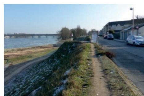
Peu de place pour les piétons et cycles quai des Augustins
