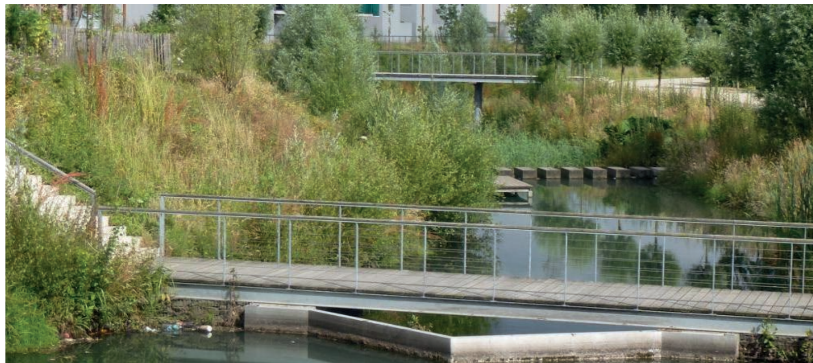
Passerelle piétonne L'ouvrage renforce le caractère naturaliste des berges du Rio par un tablier fin et la transparence des garde-corps. Source : Parc écologique à Saint-Jacques-de-la-Lande
