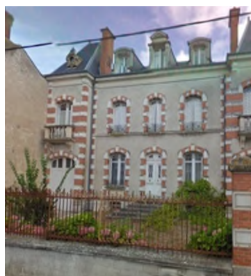
20 rue du Mal Leclerc
