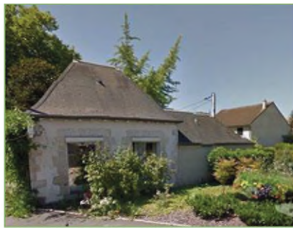
ANCIEN GRENIER À SEL
