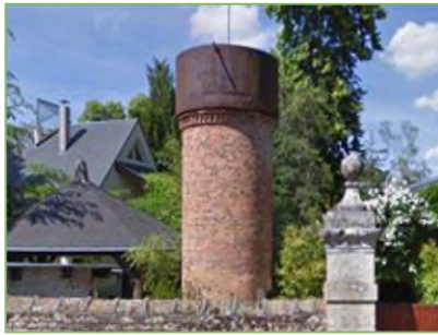
CHÂTEAU D'EAU EN BRIQUES
