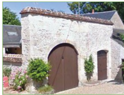
MUR AVEC PORCHE
