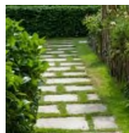
Pavés à joints enherbés
