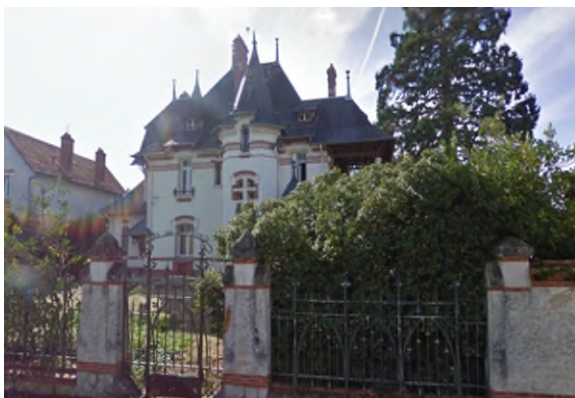
Clos des Moulins « villa Debienne » -
