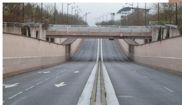
Trémie Jean Zay (Agglo) Réfection des parements
