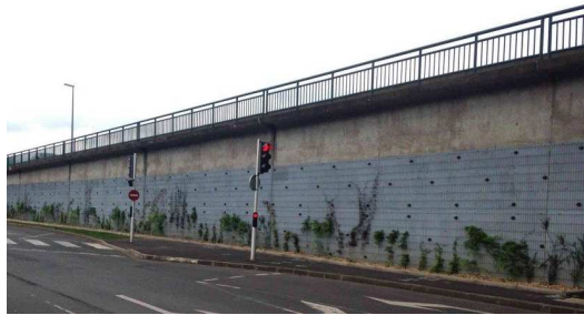
Trémie route d'Olivet / Rd 2020 Végétalisation et aménagement des cheminements piétons
