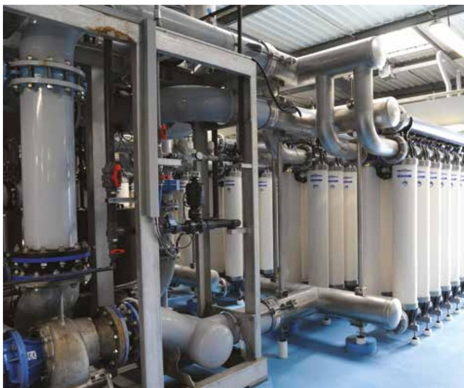
Grâce à l'usine de La Source, les taux de fer et de manganèse sont abaissés respectivement de 0,32 à 0,01 mg de fer par litre (pour une référence de qualité de 0,2 mg/l) et de 0,28 à 0,02 mg de manganèse par litre (pour une référence de qualité à 0,05 mg/l).
